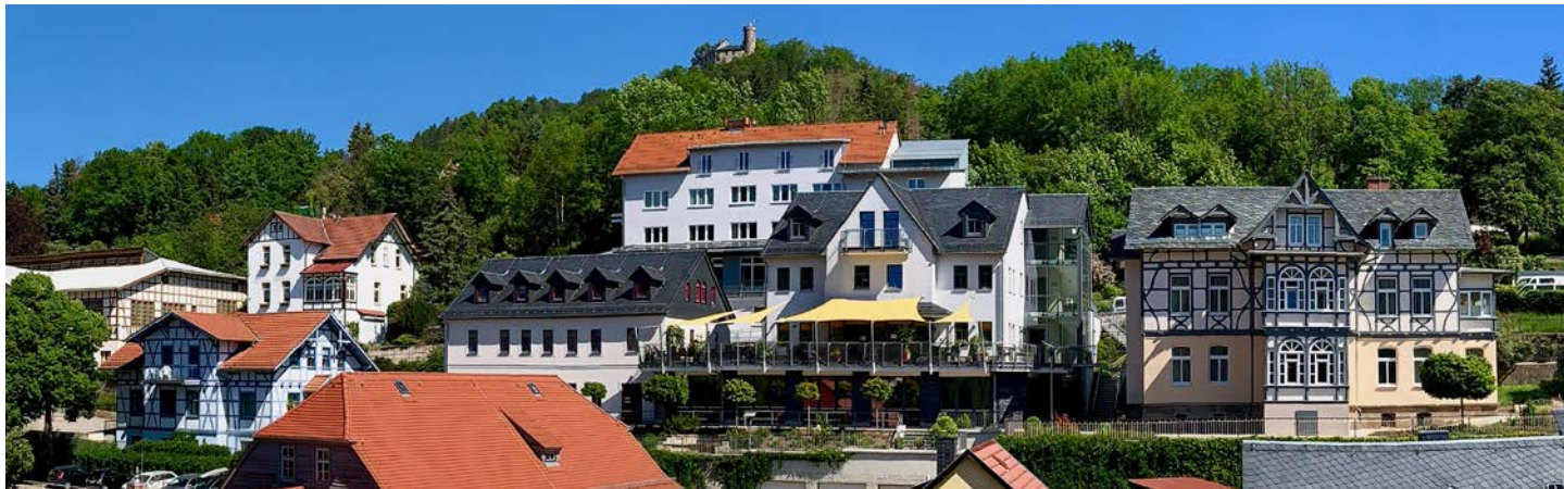
Das Gelände des Evangelischen Allianzhauses in Bad Blankenburg
